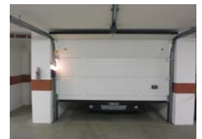
CHIUSURE AI PIANI MOTORIZZATE COMPLETE DI INTERRUPTORE DI SICUREZZA A PONTE ASPORTABILE
